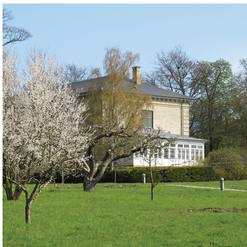
Fig.6. Billede af Fyrrehus set fra vest, hvor den nye retspsykiatri er under opførelse.
